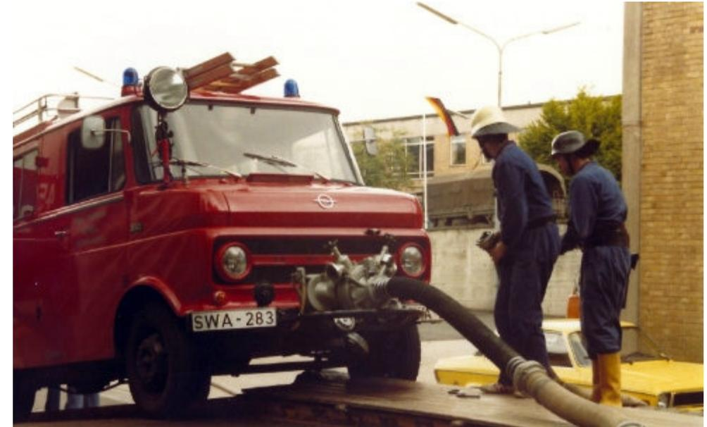
Löschgruppenfahrzeug LF8 mit Vorbau-Pumpe (1970)
